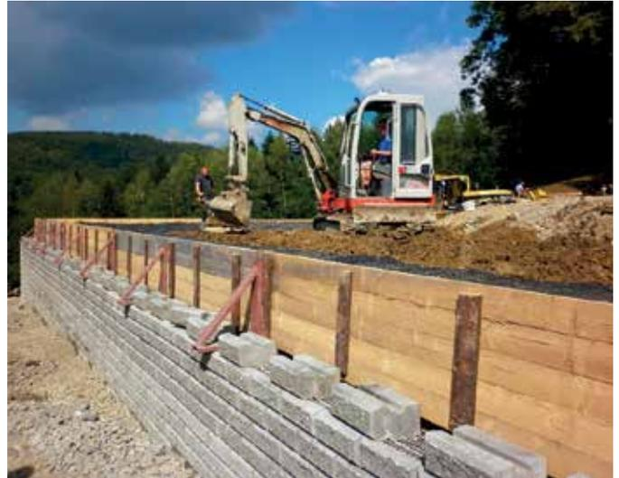
Nach Abklingen der Setzungen und Deformationen des Erdblocks wird die Außenhaut aus Blockbetonsteinen lagenweise errichtet, wobei der Zwischenraum mit einer Dränschicht verfüllt wird (zum Beispiel Kies) und die Nebenbewehrungen zwischen den Blockbetonsteinen verankert werden.
