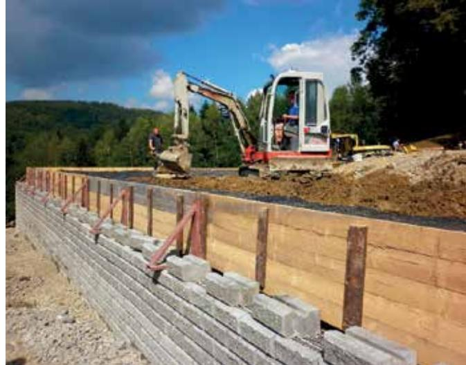
Nakon dorade klizišta i deformacija pojačanog bloka, ispred njega se može ugraditi završni sistem obloga, primjenom metode sloj-po-sloj. Razmak između blokova i prednjeg dijela zemlje pojačanog tla ispunjen je drenažnim slojem (na primjer šljunkom), a sekundarni umeci su usidreni između betonskih blokova.
